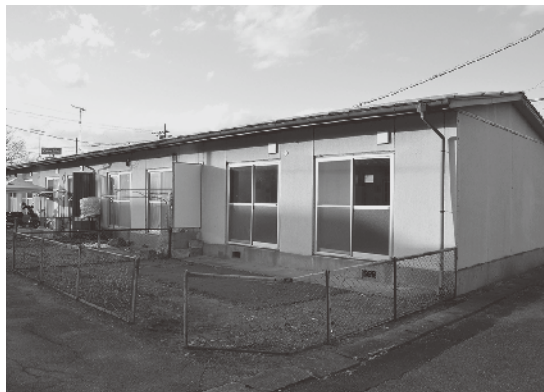
建築年次が古い町営住宅
