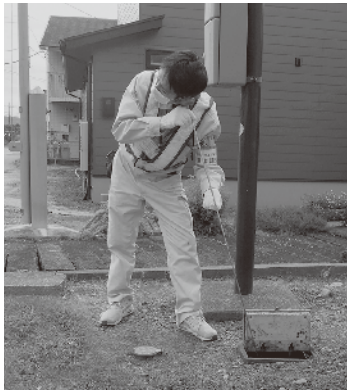
委託業者による漏水調査
