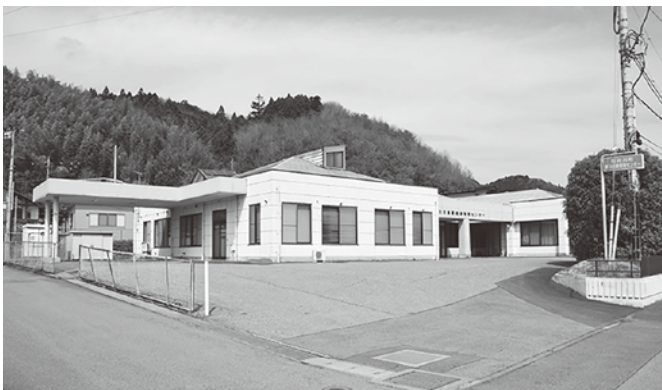
老朽化により廃止となる健康管理センター
