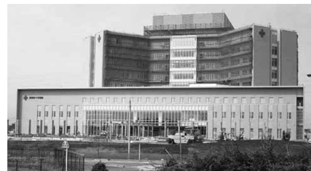
建設中の那須赤十字病院
