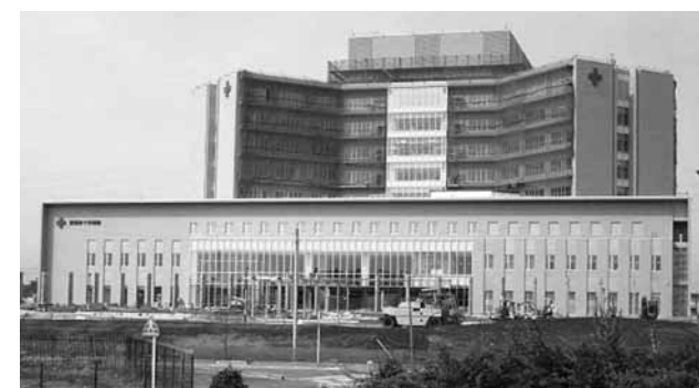
建設中の那須赤十字病院
