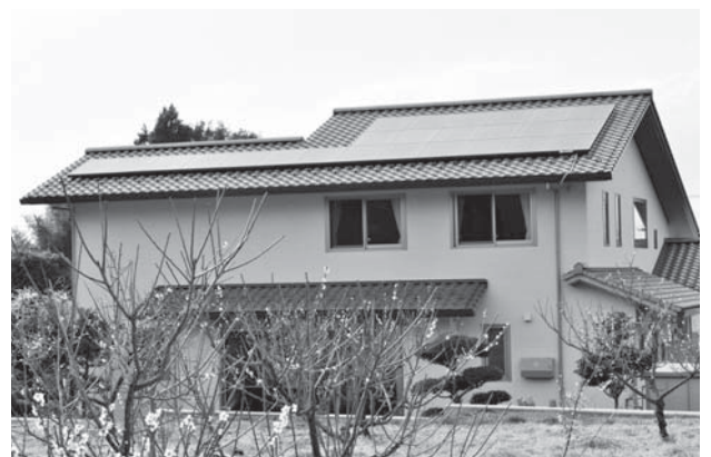
太陽光発電施設
