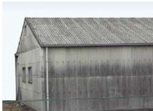
石綿含有スレート波板（屋根・外壁）
