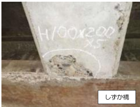
写真 3-3-33 剥離・鉄筋露出
