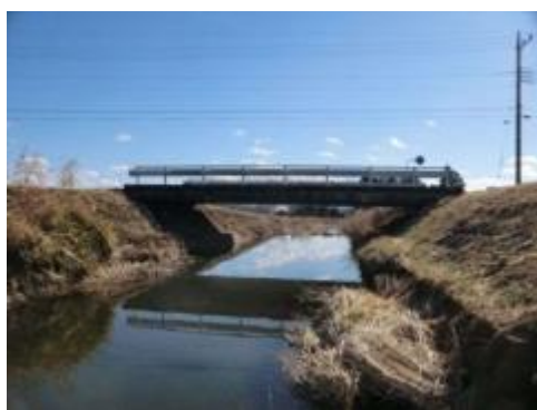
写真 2-2-3 山崎橋（権津川 橋長 16m）
