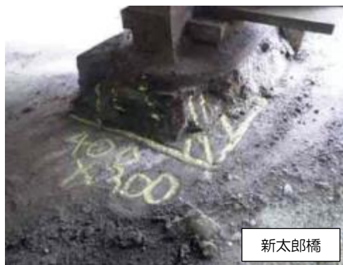
写真 3-3-44 変形・欠損
