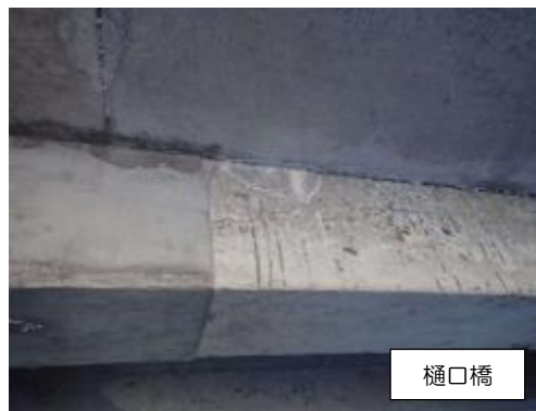
写真 3-3-8 漏水・遊離石灰
