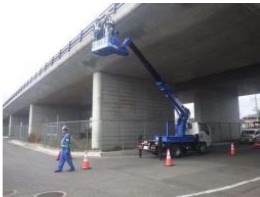
写真 3-1-1 定期点検のイメージ (高所作業車)
