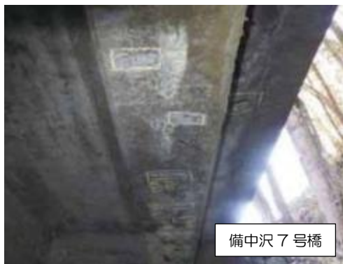
写真 3-3-7 剥離・鉄筋露出(2)
