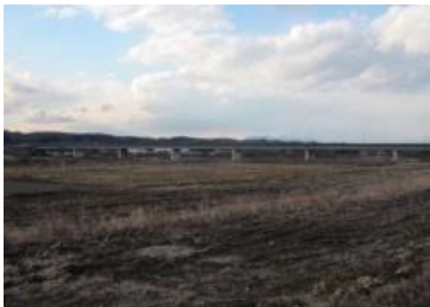
写真 2-2-1 八溝大橋（那珂川 橋長 383m）
