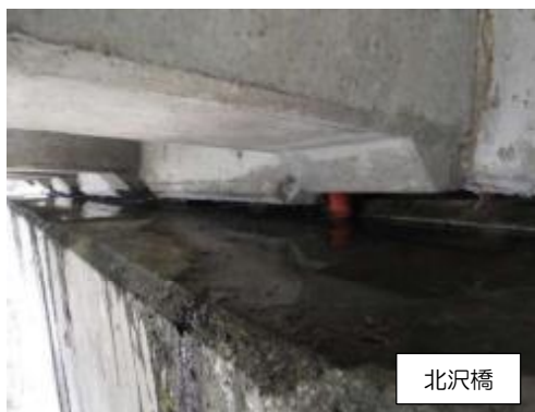
写真 3-3-47 漏水・滞水
