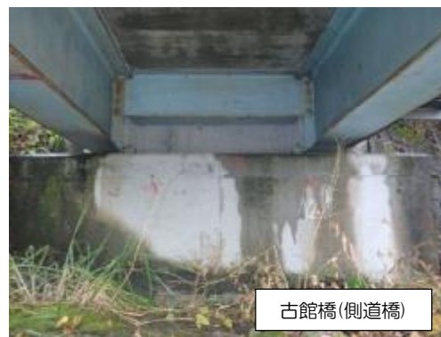
写真 3-3-40 漏水・滞水
