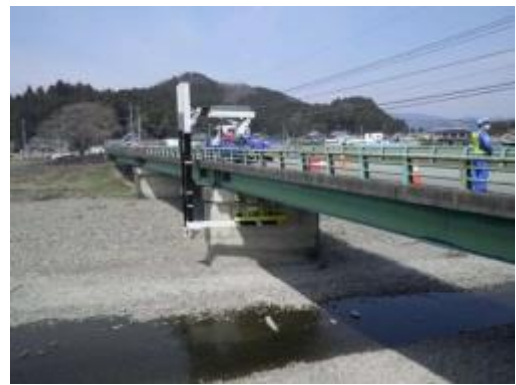
写真 3-1-2 定期点検のイメージ (橋梁点検車)
