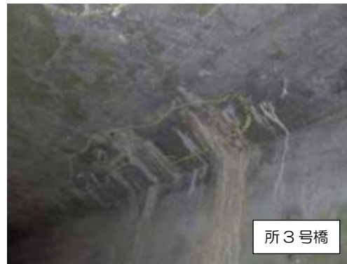
写真 3-3-18 漏水・遊離石灰
