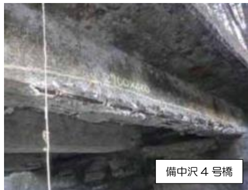
写真 3-3-6 剥離・鉄筋露出(1)
