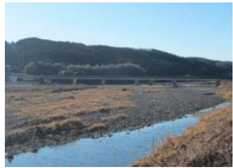
写真 2-2-2 浄法寺橋（箒川 橋長 218m）
