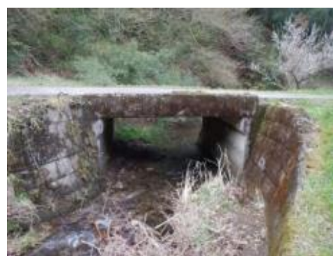
写真 2-2-4 萩の越路橋（樋川 橋長 4m）
