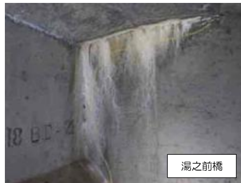
写真 3-3-34 漏水・遊離石灰
