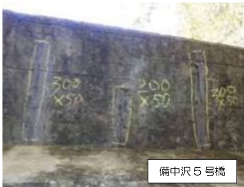
写真 3-3-17 剥離・鉄筋露出
