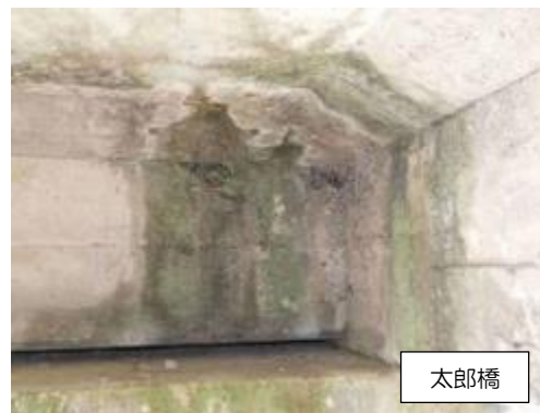
写真 3-3-32 漏水・滞水
